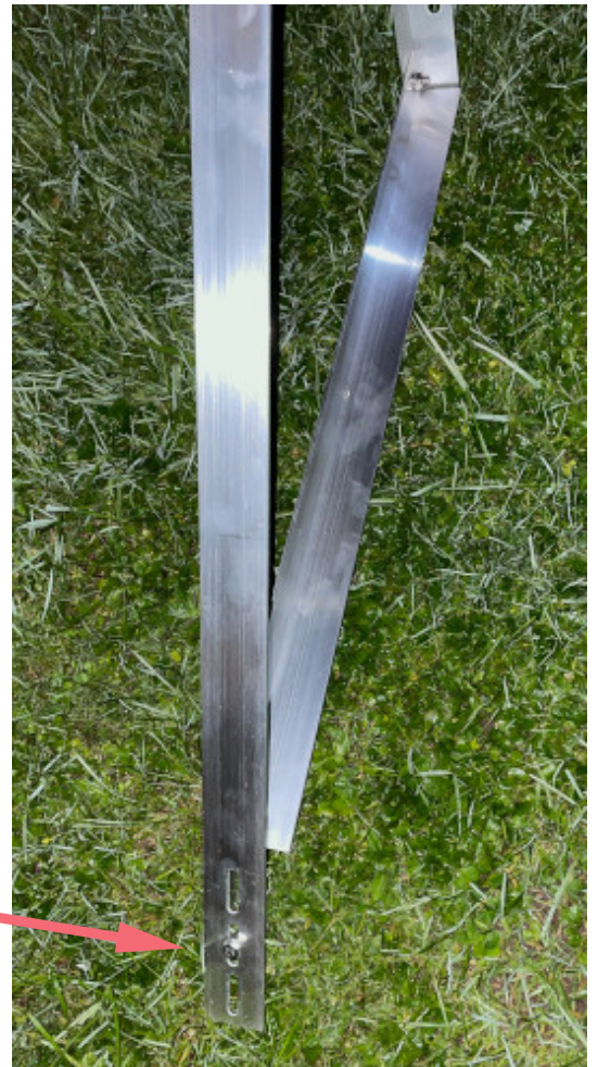
Sicht auf das Modulprofil untere Langlöcher für die Montage des PV Moduls Je nachdem welche Breite das Modul hat
